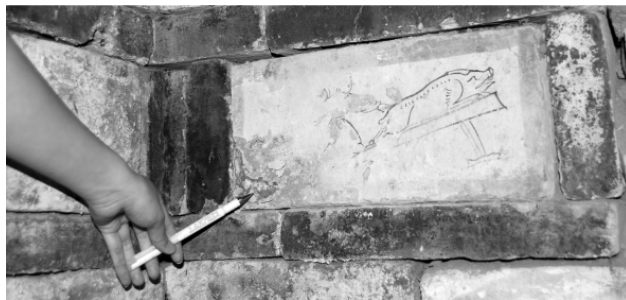
图 2 嘉峪关新城魏晋壁画砖颜料层起甲、剥落
