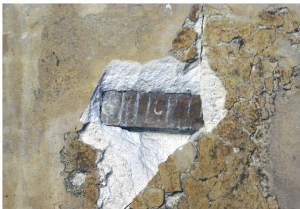
图三 石膏支撑体壁画断裂脱落病害
