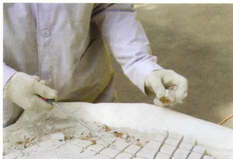
图16 分块剔除地仗背部石膏
